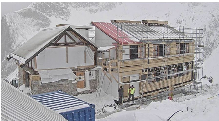
Im September kam ein kurzer und heftiger Wintereinbruch, Rohbau wurde schnellstens abgedichtet.
