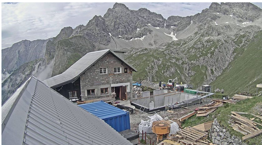
Anstelle der alten Anbauten ist hier bereits das neue Fundament neben der Urhütte zu sehen.
